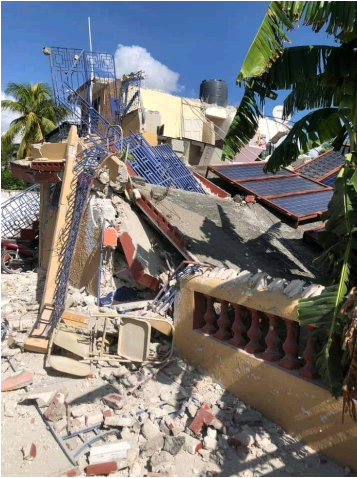
Das Erdbeben der Stärke 7,2 hat im Süden Haitis verheerende Verwüstungen angerichtet.
